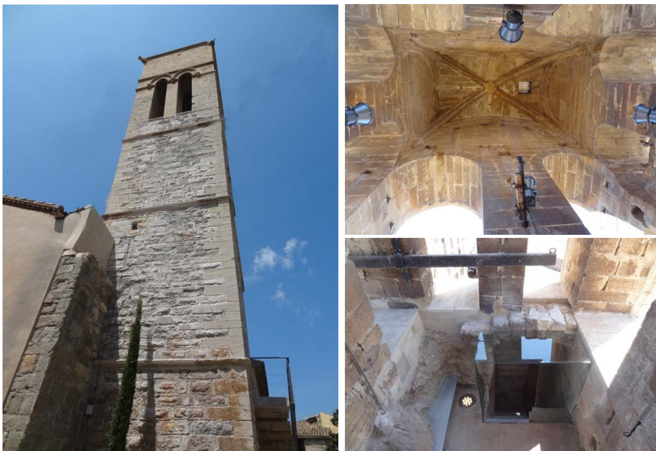
Restauració de les façanes i el pis interior amb el nou accés a les escales del campanar
