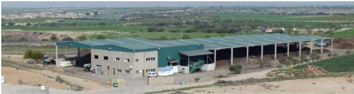
PLANTA DE COMPOSTATGE
